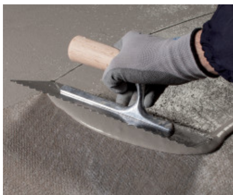
Drugi sloj Mapelastic-a Turbo preko prvog sloja ojačanog Mapetex-om Sel
