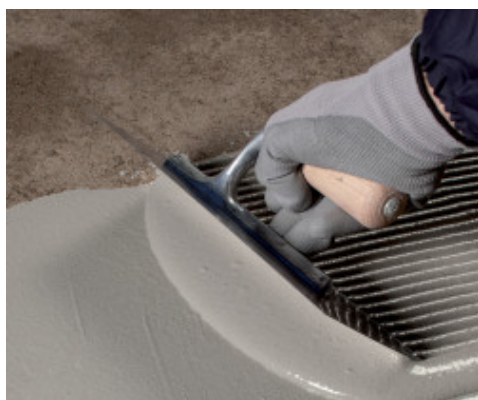
Nanošenje prvog sloja Mapelastic-a Turbo
