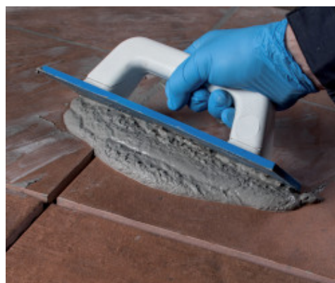
Fugiranje pločica Ultracolor-om Plus
