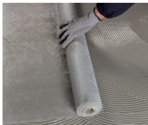
Polaganje Mapetex-a Sel u prvi svježi sloj Mapelastic-a Turbo
