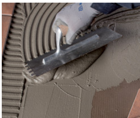
Lijepljenje pločica Elastorapid-om
