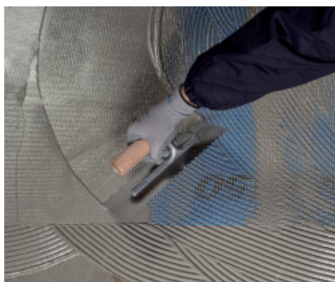
Polaganje Mapenet-a 150 u prvi svježi sloj Mapelastic-a Turbo
