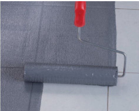
Nanošenje premaza Eco Prim Grip Plus valjkom na postojeće porculanske pločice
