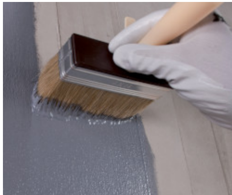
Nanošenje temeljnog premaza Eco Prim Grip Plus četkom na beton
