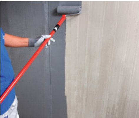
Nanošenje temeljnog premaza Eco Prim Grip Plus valjkom na beton
