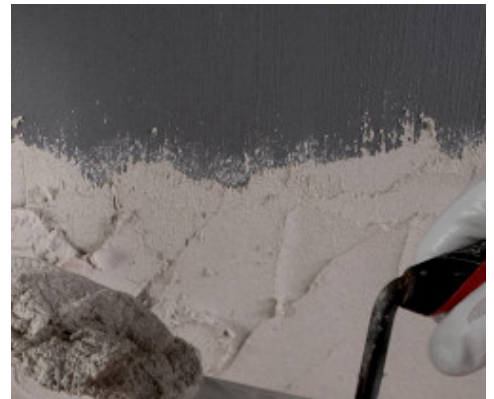
Nanošenje žbuke na Eco Prim Grip Plus
