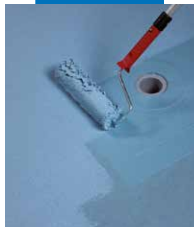
Nanošenje drugog sloja Mapelastic AquaDefense valjkom
