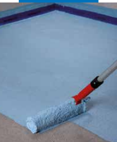
Nanošenje prvog sloja Mapelastick AquaDefense na estrih
