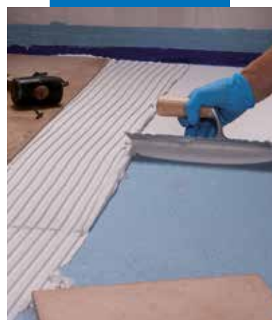
Polaganje keramičkih pločica na Mapelastic AquaDefense
