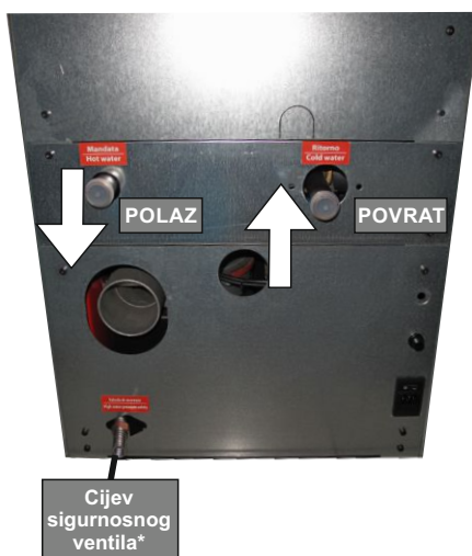
Slika 5. Polaz, povrat i cijev sigurnosnoga ventila
