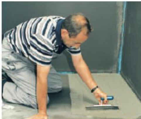
Ljepila za pločice s dodatkom PCI Lastoflexa smanjuju izduživanja podloge i kompenziraju naprezanja prouzročena varijacijama temperature.
