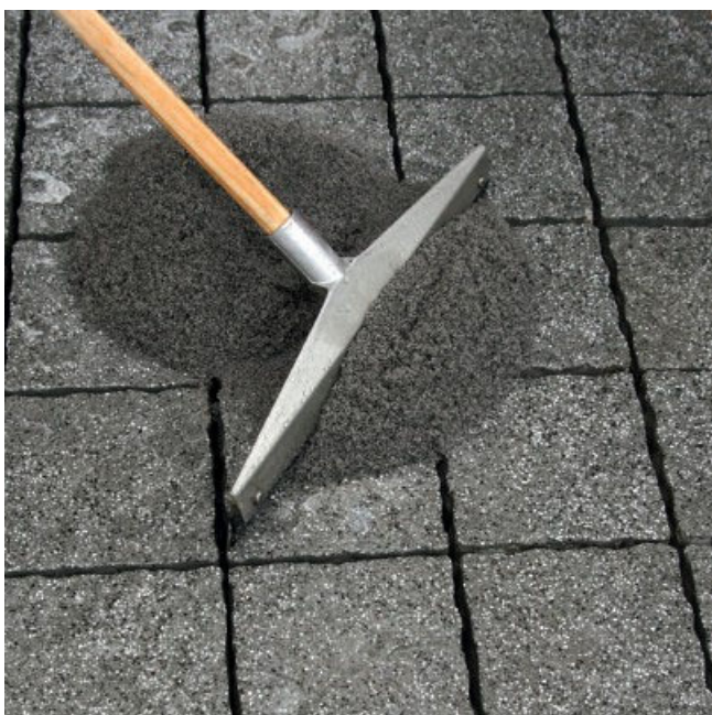
Utisnuti PCI Pavifix 1K Extra u fugu koristeći metlu s tvrdom gumom.
