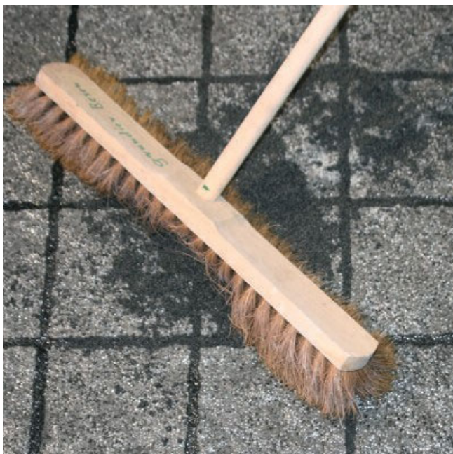
Mekanom metlom ili četkom ukloniti višak i ostatke mase.
