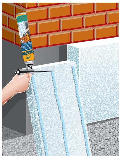
Poliuretansko ljepilo za bitumenske podloge je nisko ekspandirajuća jednokomponentna poliuretanska pjena namijenjena za pričvršćivanje izolacijskih materijala pomoći montažnog pištolja na bitumenske podloge. Učvršćuje se pomoću vlage iz zraka.
