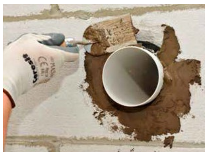
Postavljanje s Ceresit CX 5 Express reparaturnim mortom (prethodno navlažena podloga)
