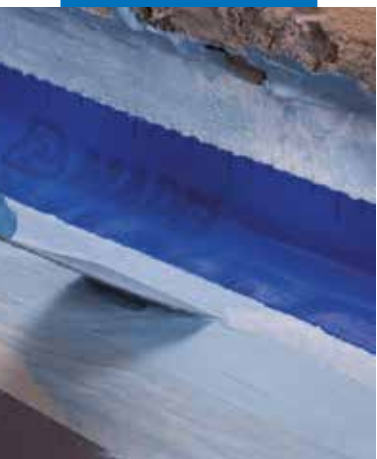
Ugradnja Mapeband-a u Mapelast ic AquaDefense na spoju pod-zid
