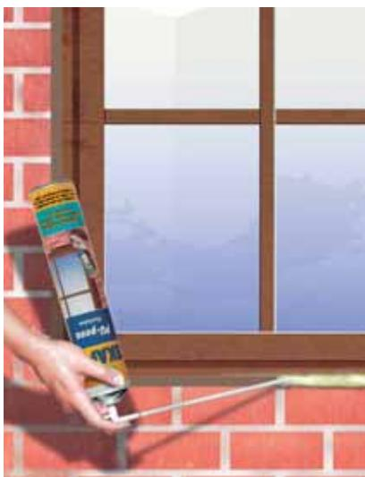
TEKAPUR PU - montažna pjena je jednokomponentna poliuretanska pjena, koja se stvrdnjava uz pomoć vlage zraka.
